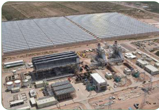
Figura 5. Planta Agua Prieta II.
