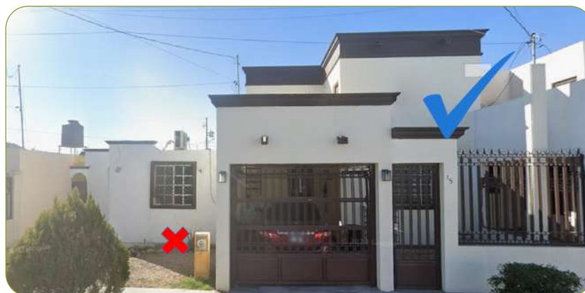
Figura 9. Ejemplos de acometidas. A la izquierda con una cruz en rojo es una acometida instalada originalmente por la constructora durante los años 80s.
